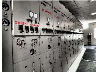
バルカンペット変電所の制御盤
