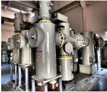
GIS ユニット(パティガダ変電所)
