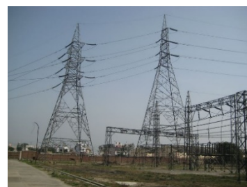
送電線 (Samalhka 変電所)
