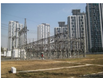
Sector 72 (Gurgaon 地区) 変電所
