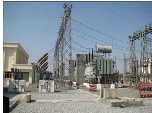
Sector 20 変電所 (グルガオン地区)
