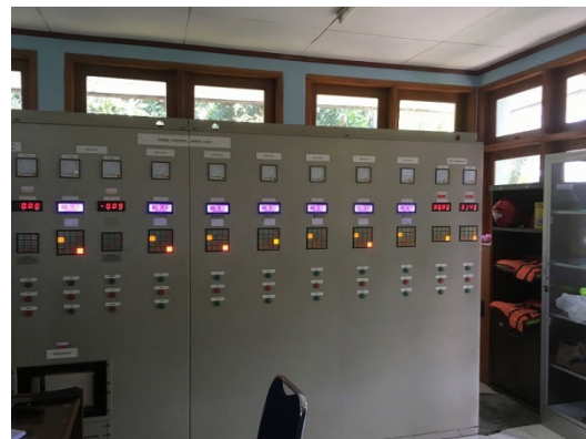
写真 2: ババット堰の水門制御室
