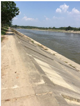
写真 1: ババット堰周辺の護岸壁
