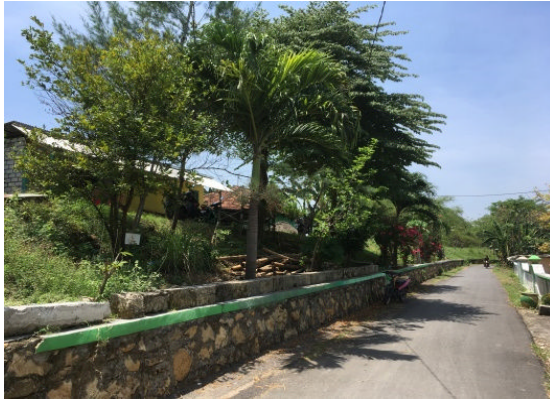
写真3：建設された堤防 (トゥバン地区)
