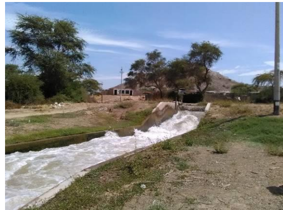
整備された水路（ランバイエケ県）
