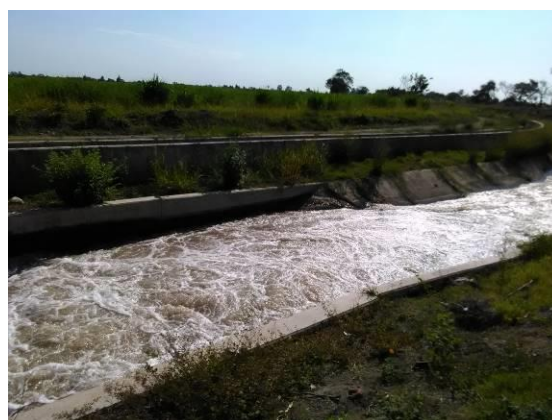
整備された水路（ランバイエケ県）
