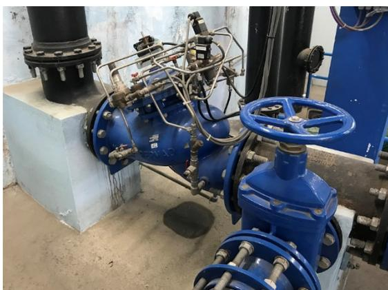
SCADA に接続された配水池のバルブ類
