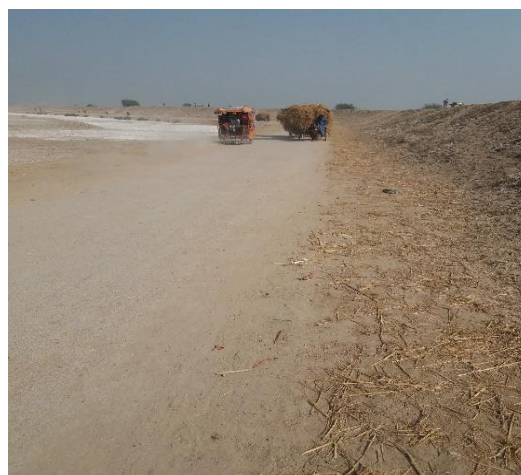
整備された道路(ダドゥ県 2018年)
