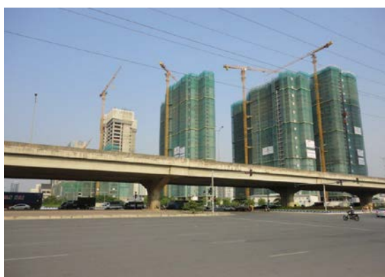
環状3号線道路（一般道より撮影）
