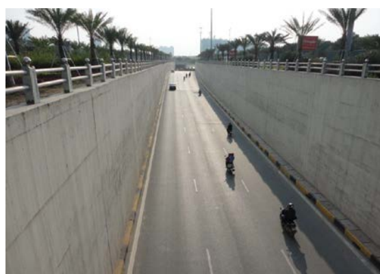
既存道路に整備されたアンダーパス
