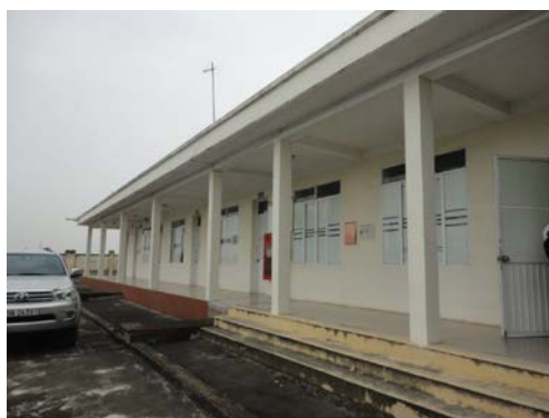
本事業で建設された変電所の建物 (ハノイエン省イェンミー変電所)
