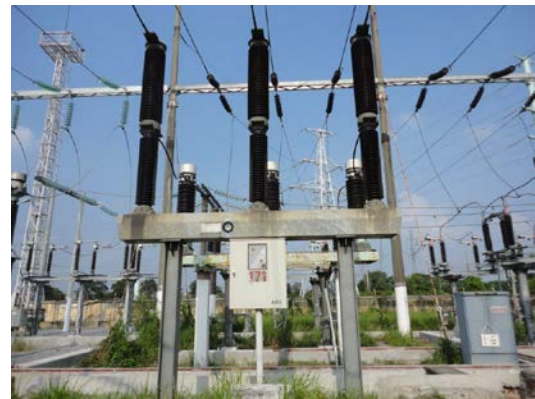
クアンミン変電所（ハノイ市）
