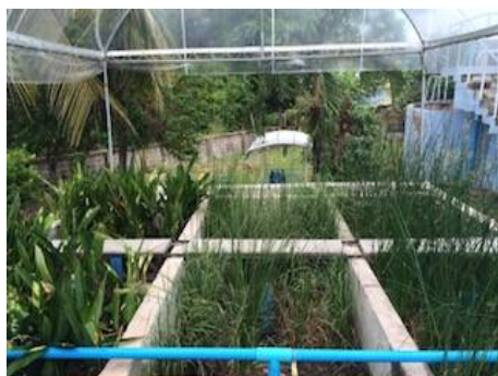
水生植物による浄水のための人工湿地
