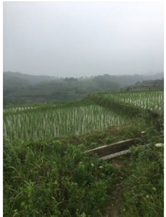
(2) 本事業で復旧した陝西県蔡河村の水路
