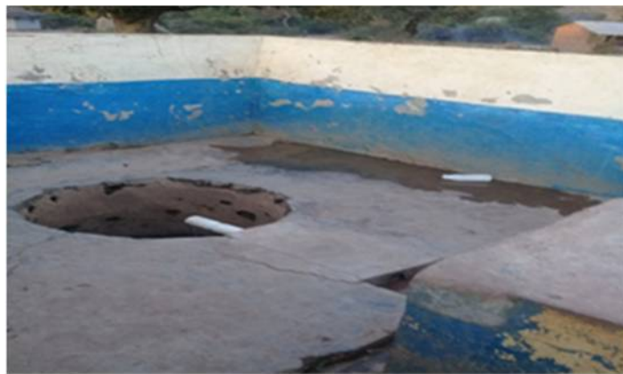
モロシヨ給水施設では、水料金徴収、研修が行われ、適切な衛生状態が維持されている。
