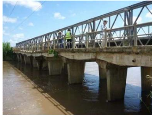
改修予定の橋梁 (JICA 提供資料)
