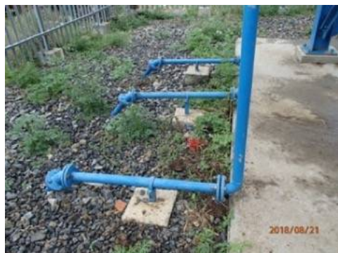
Corner Kilak の配水パイプ。損傷はない。
