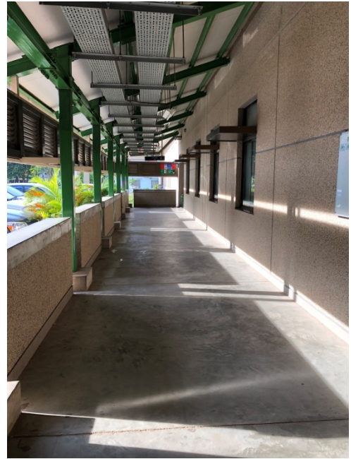
渡り廊下 救急・画像・手術棟
