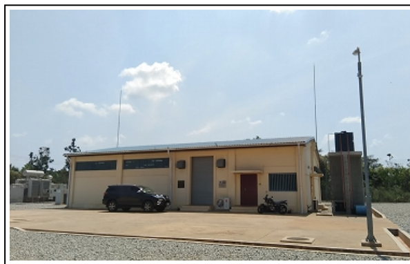
コトクロム一次変電所（スンヤニ）
