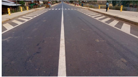
本事業によって整備された道路（ルマメ市）
