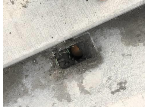
写真 4 定期清掃前の排水溝の様子
