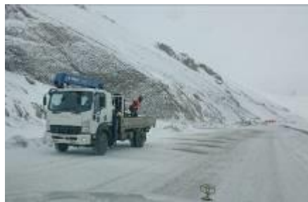
写真 5 滑り止め材を撒く作業員
