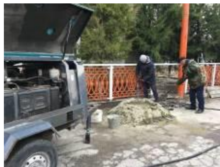
写真 2 エアーコンプレッサを用いて 路肩の修繕を行う様子
