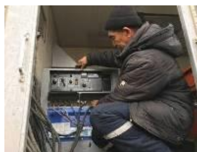
写真4 移動修理車の中
