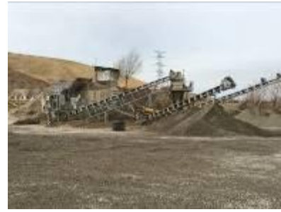
写真8 骨材プラント
