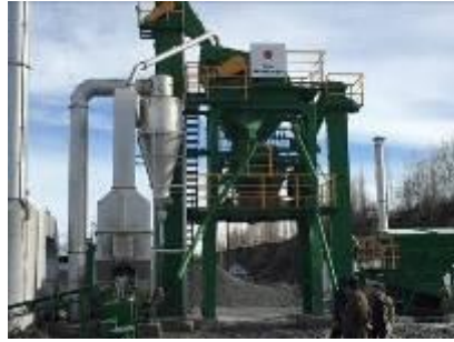
写真7 アスファルトプラント
