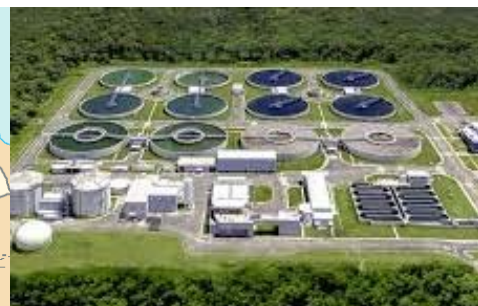
フアン・ディアス下水処理場
