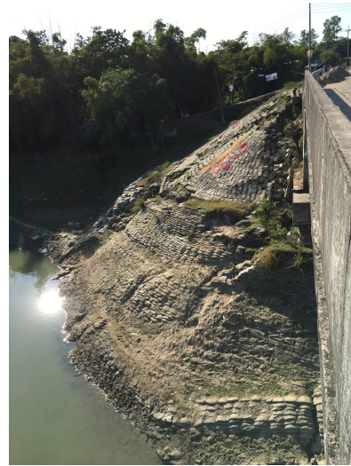
護岸部分の損傷 (地方幹線道 280 号線 038c 橋)
