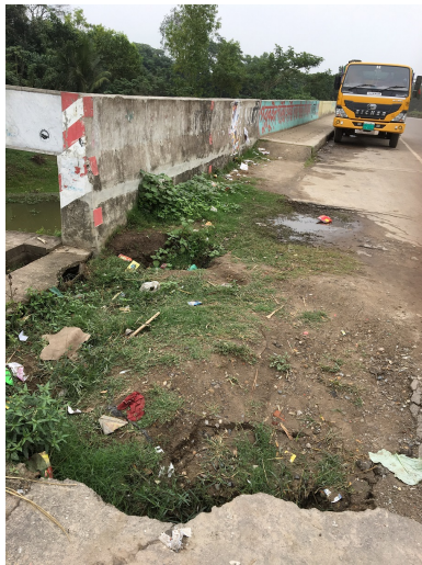
アプローチ道路と橋台の間の損傷 (国道 102 号線 035a 橋)
