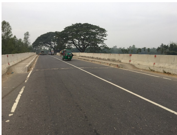
本事業により整備された橋梁 国道4号線 106a 橋 (ダッカ地域)
