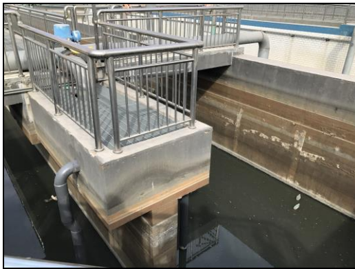
稼働停止中の第 3 下水処理場
