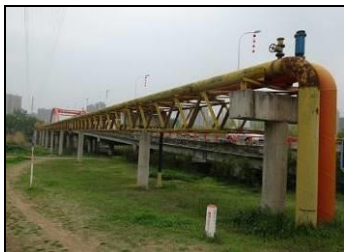
本事業により整備された五河 県の下水道管
