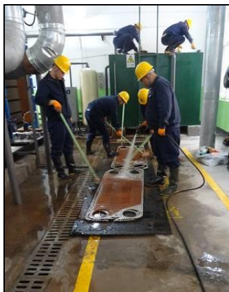
本事業によって整備された熱交換ステーションの熱交換器プレート定期メンテナンスの様子
