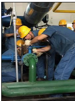
本事業によって整備された熱交換ステーションでの技術研修の様子
