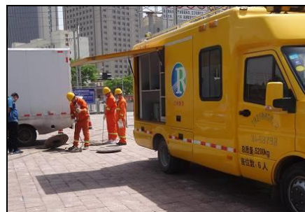
本事業によって整備された熱供給管のメンテナンスの様子
