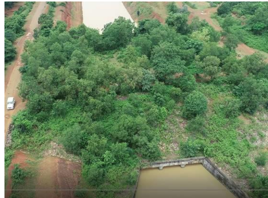
図 5 空中から水路をまたぐ象の移動用の橋 （日本工営提供）
