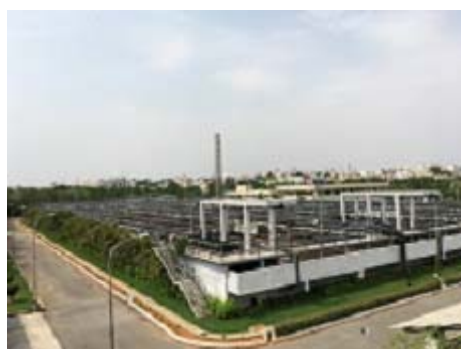
30,000m 3 /日 下水処理場
