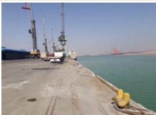
本事業により整備されたバース
