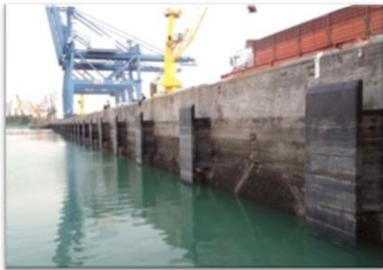
写真 1：本事業により整備された フェンダー 12
