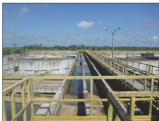
本事業にて建設された下水処理場
