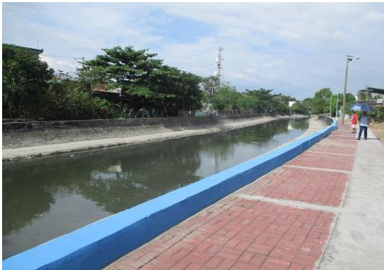
本事業により整備された排水路
