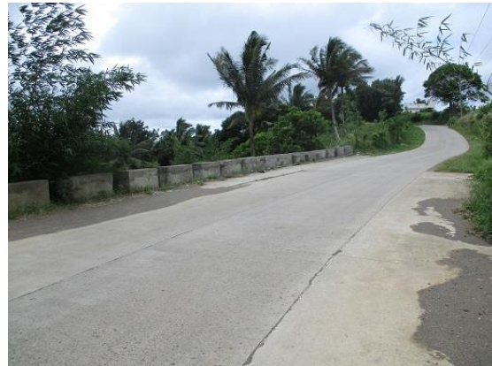
サブローン事業で舗装された農道。沿道には、トマト畑やサトウキビ畑が点在する。（バタンガス州）
