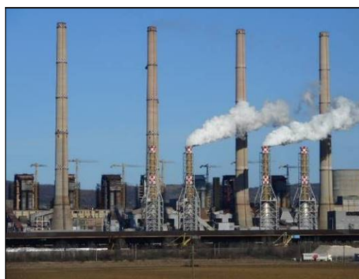
FGDは手前4つの吸収塔を含む装置
