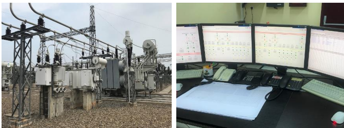
キリノッチ変電所：(左) 変圧設備、(右) 監視パネル
