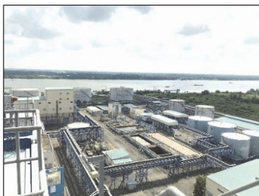
写真 1 オモン発電所 燃料タンク
