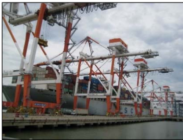
バース及びコンテナ用クレーン
