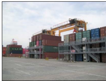
コンテナヤード
