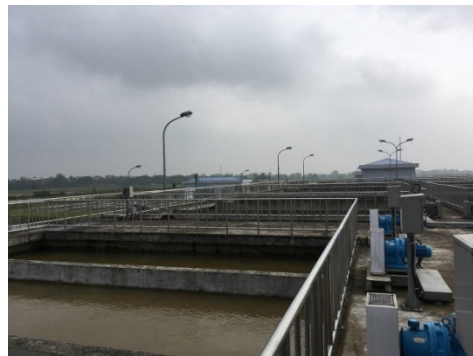
写真 2：整備された浄水場 (ビンイェン浄水場)
