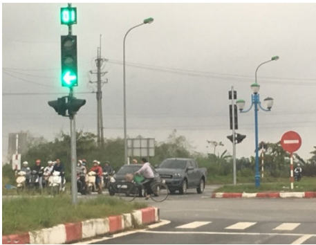
写真 1：道路上に設置された信号機
