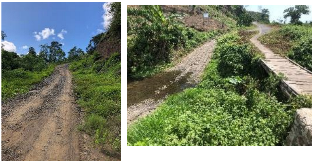
未舗装区間と小橋建設予定地
