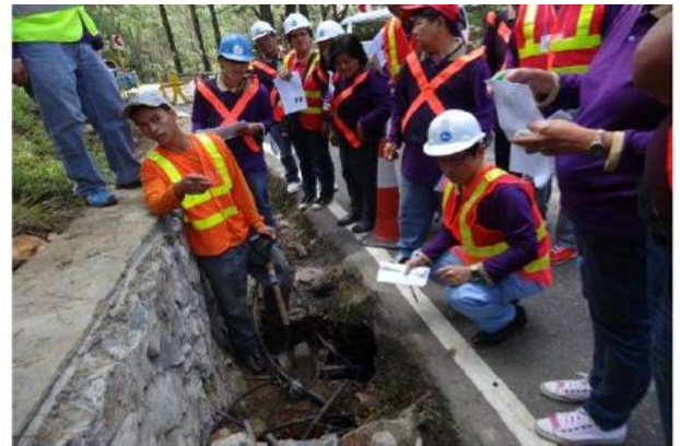
橋梁診断の様子
