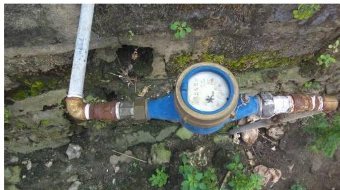
各戸接続された水道メーター:フェーズ 1 プロジェクトで使用された旧式の水道メーター（マカダラ地区）
