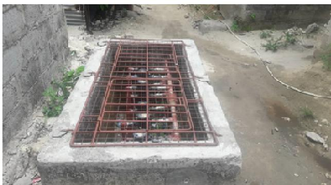
フェーズ 2 プロジェクトで導入された 10 世帯分の住宅接続水道メーターを示すマニホールド（マカダラ地区）
