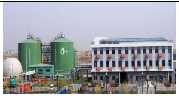
青島市食品廃棄物処理センター。中国側が整備し2013年より稼働。本プロジェクトで得た知見等を活用し運用中。
