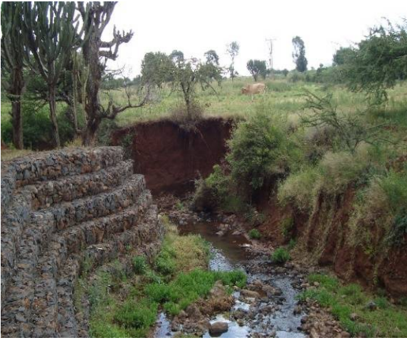
イシオロサブ川流水区にて本事業期間中に建設された護岸の様子
