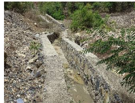
ERA により建設された側溝
