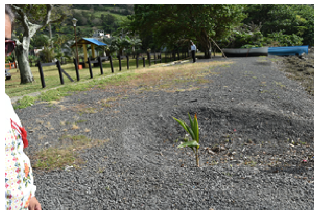
漁業従事者の作業スペースを確保して設置された、グラン・サブル沿岸のフレキシブル護岸
