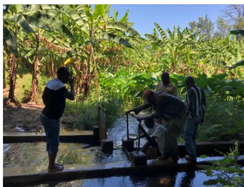
本事業で建設した取水堰と水利組合員
