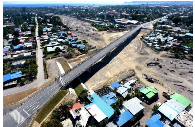
CBD の環状道路の整備と交通管理（コモロ橋梁 3）
