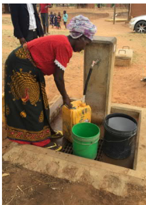
レベル2 給水施設（タボラ市）
