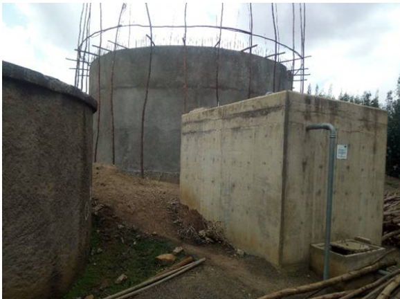
貯水槽（左：既存貯水槽、右：本事業で新設したもの、後方：コミュニティの追加によりTWUが新たに建設したもの）
