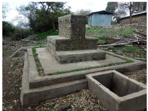
地下水が出ないために放棄された公共水栓
