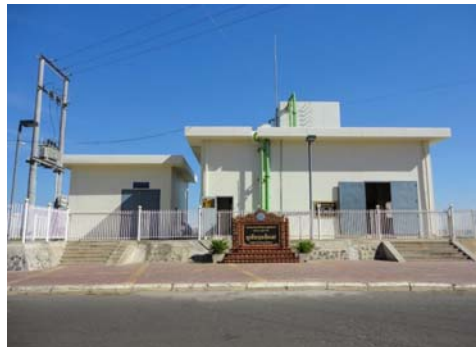
取水操作室・発電機室（建屋外観） (コンポンチャム)
