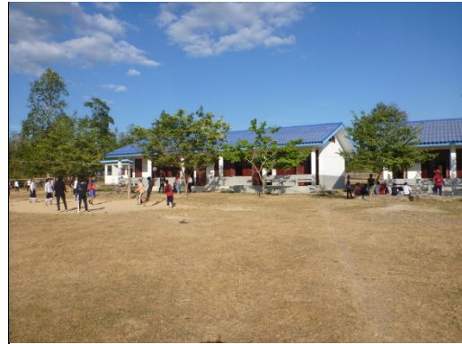
本事業で建設された校舎
