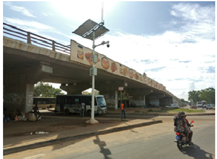
ティアロエ交差橋
