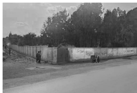
パイロット事業で改修された学校外壁
